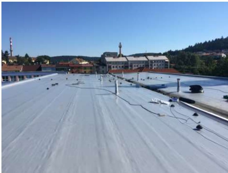
Oprava střechy na budově 2. stupně
